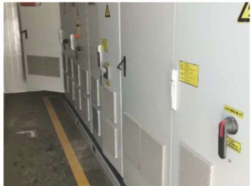
光伏发电_逆变器柜组
