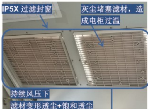
光伏发电_逆变器柜组
